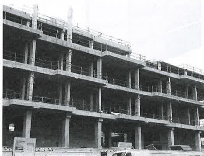
Photo 1. Bâtiment à ossature poteaux-poutres en béton.
