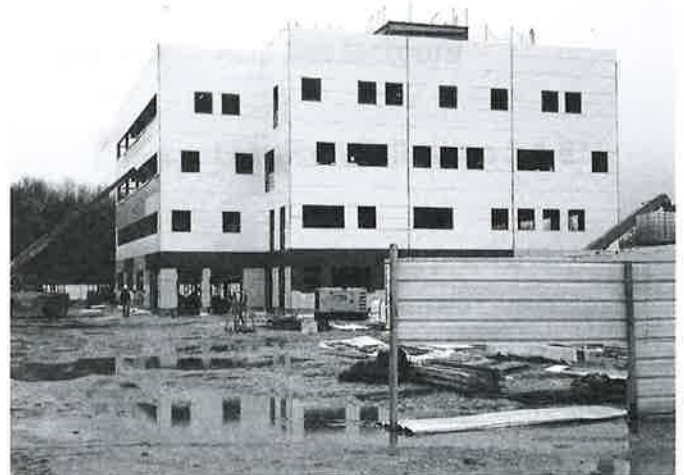
Photo 3. Façade filante avec appuis multiples.
