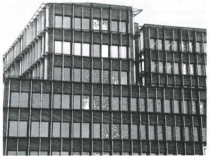
Photo 2. Façade filante avec appuis multiples.
